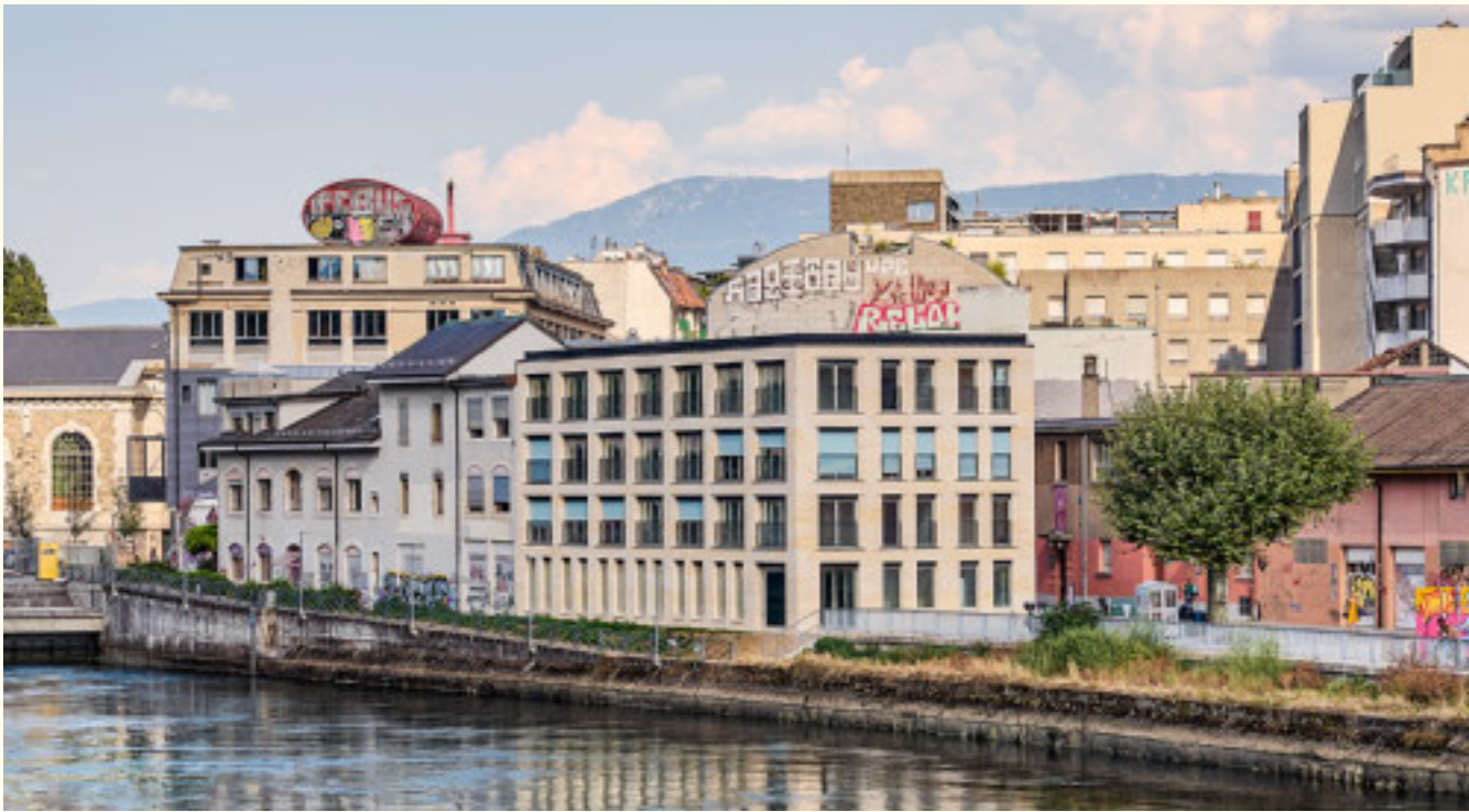
Sozialwohnungen aus tragenden Natursteinwänden – in der Schweiz bereits möglich, wie hier in Genf bei einem Projekt der Büros Archiplein und Perraudin. Foto: Perraudin Archiplein Consortium
