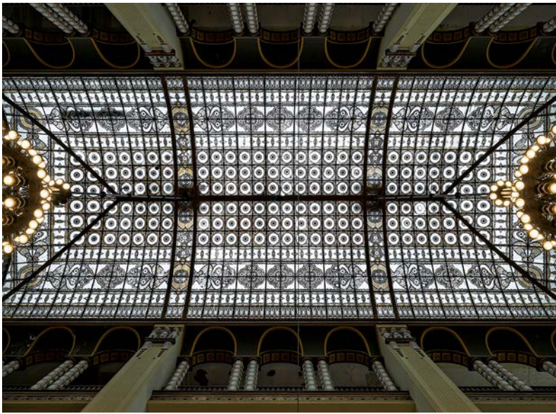
Das Glasdach trägt ornamentale Jugendstilmalereien.
