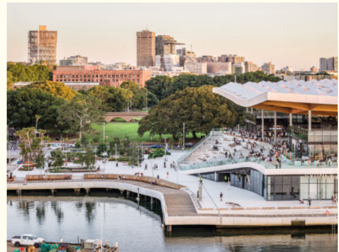
Rund 2500 Tonnen wiegt das Dach, das aus 594 Brettstichholzträgern und 407 pyramidenförmigen Aluminiumkassetten besteht. Die Kassetten reflektieren indirektes Tageslicht und schützen gleichzeitig vor direkter Sonneneinstrahlung.
