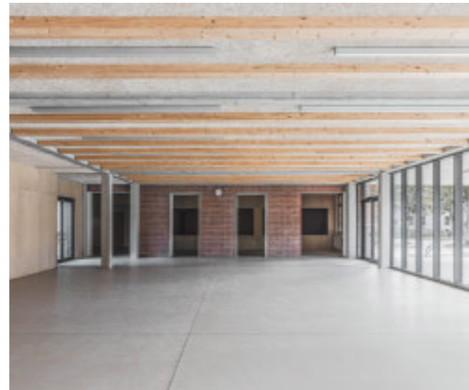
Der Neubau wurde als Stahlbeton-Skelett mit vorgefertigten Holzrahmenelementen und einer Ziegelfassade errichtet. Rechtes Bild: Blick in die Mensa
