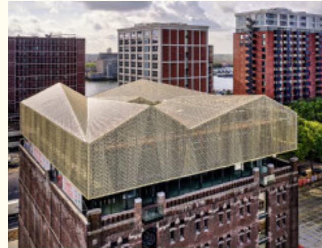
Den Speicher krönt nach der Transformation eine semitransparente Dachskulptur aus perforiertem Aluminium, die über dem Bestand zu schweben scheint. Fotos: Hans Wilschut
