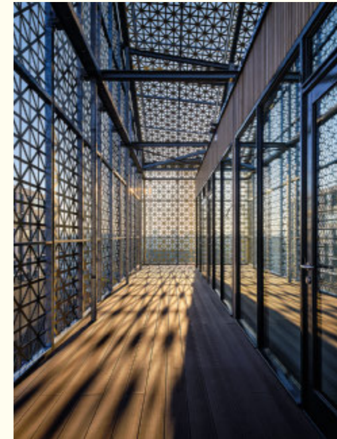
Die perforierte Aluminiumhaut, die als gefaltete Schale den Konturen des Bestandsgebäudes folgt, soll als eine zeitgenössische Interpretation der Architektursprache des Speichers wahrgenommen werden. Variationen in der Perforationsdichte verleihen der Skulptur ihre Tiefenwirkung. Sie umhüllt die 16 Short-Stay-Apartments. Fotos: Hans Wilschut
