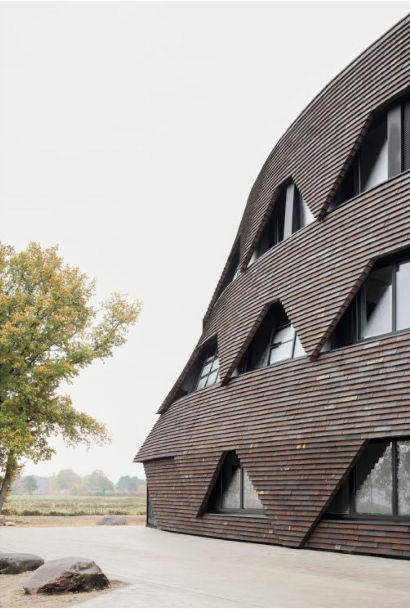
Die Fassade setzt sich aus fein geschuppten Ziegelplatten zusammen, die in vier Bändern um das Gebäude laufen und sich geschossweise leicht überlappen. Foto: Hannes Heitmüller
