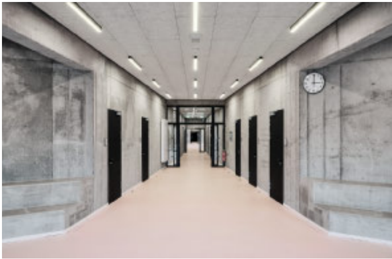
Die Sichtbetonwände im Eingangsbereich legen die Konstruktion der Schulbauten offen: Massivbauweise in Ortbeton. Fotos: Hannes Heitmüller (links), Thomas Heimann
