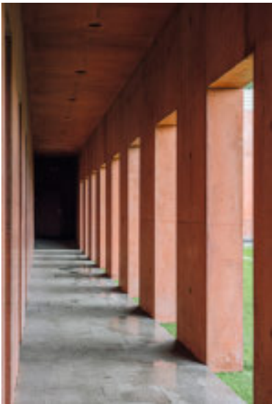
Die L-förmige Stützmauer aus eisenoxid-pigmentiertem Beton fasst Spielfeld, Erschließung und öffentliches Plateau. Die Arkade trennt Spieler- und Zuschauerbereich. Ihre rhythmisch gesetzten Öffnungen verdecken exakt die dahinterliegenden Zugänge. Schnitt im Maßstab 1:1500
