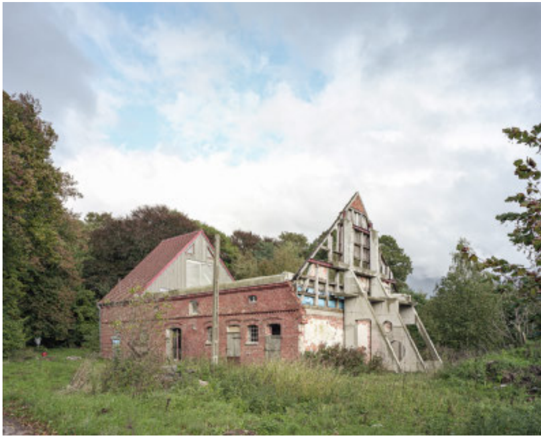
Drei skulpturale Betonstützen verstärken den löchrigen Fachwerkgiebel, der keine tragende Funktion mehr hat. Auch die Außenwände müssen keine Lasten stemmen – die eingesetzte Betonplatte wird von neun Pfeilern getragen. Grundriss Erdgeschoss und Schnitt im Maßstab 1:250
