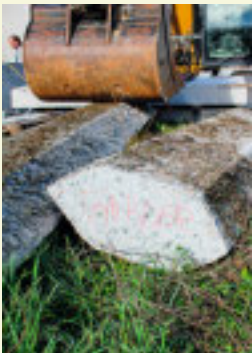
„Behalten“ steht auf dem ausgeschnittenen Beton- teil, es wird zur Sitzbank vor dem Becken. Die Wasser- rinnen und -becken wur- den aus dem Beton ausge- schnitten.
