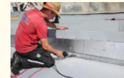
Bei einer Dachneigung von zwei Grad ist die Dachbahn direkt an den Berg angeschlossen, damit das Regenwasser sowie die Lawinen, Schnee oder Geröll, darüber hinweggehen können und die Dachabdichtung nicht beschädigen. Fotos: frischbier-plan-gmbh (großes Bild), Sika Deutschland CH
