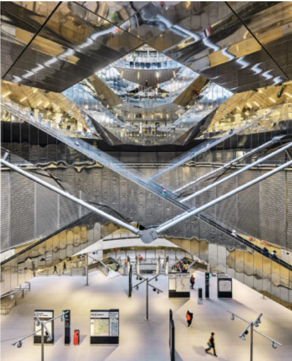
Die langen Rolltreppen werden von speziellen Haltekonstruktionen unterstützt. Eine Verteilplattform auf Ebene -6 führt Reisende bei der Linien zusammen und zum Ausgang empor.
