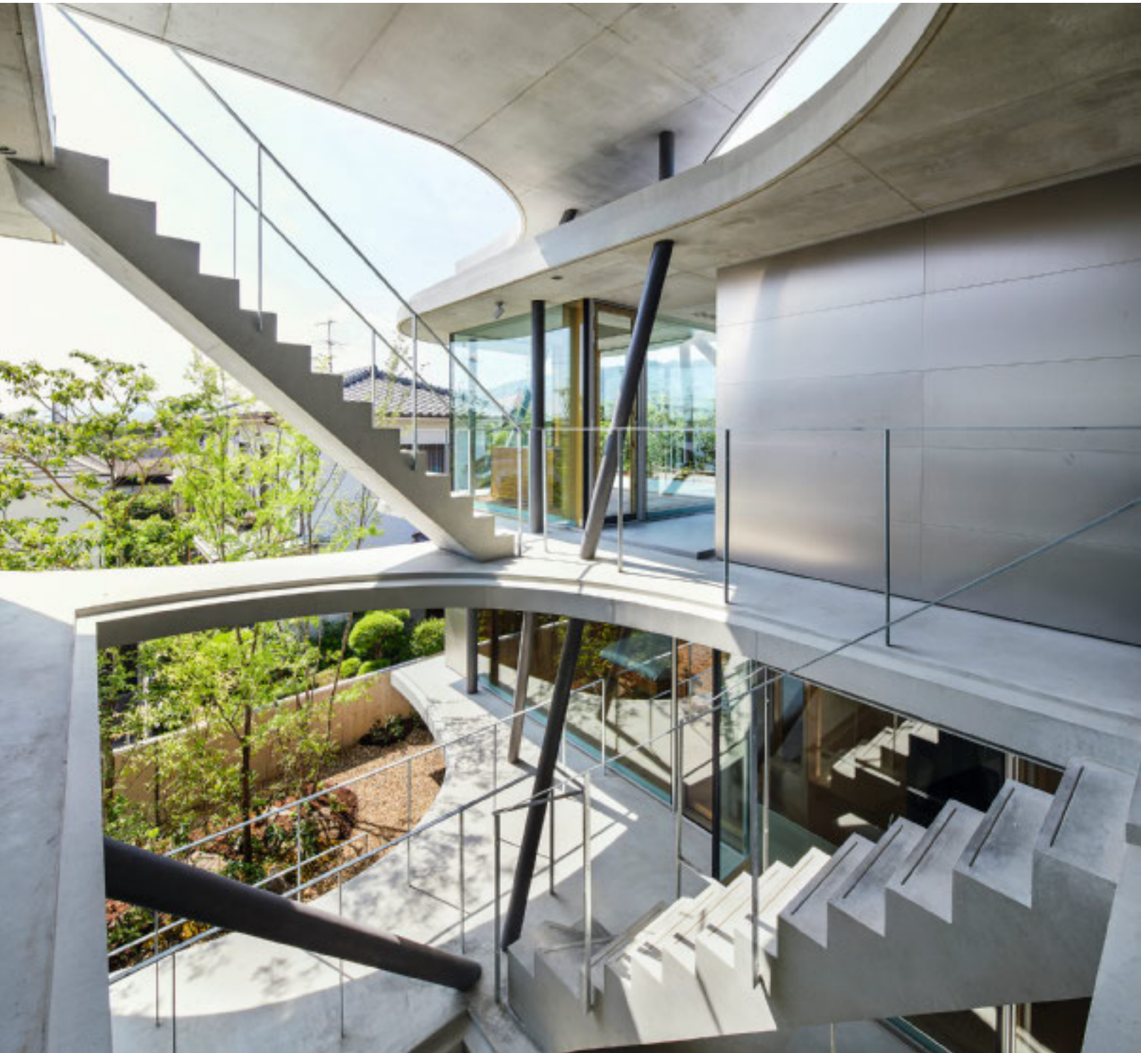
Die Wohnräume sind mit einer Glasfassade thermisch umschlossen. Treppenhaus und Flure liegen hingegen unter freiem Himmel.
