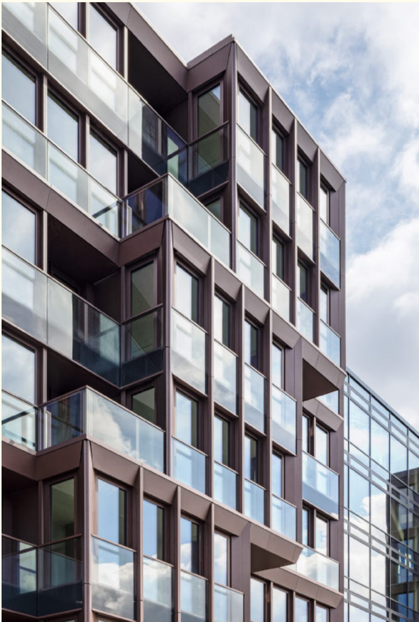
Die Hauptfassaden vom ersten bis zum sechsten Obergeschoss sind als Glaselementfassaden ausgeführt. Die Südseite zur Spree gliedern vorspringende, versetzt angeordnete Erker mit darüberliegenden Balkonen.
