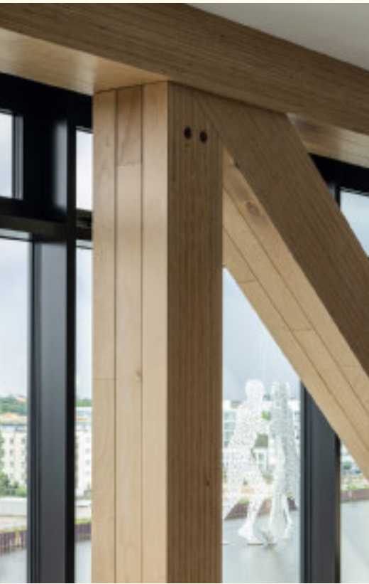
Der gläserne Verbindungsbau zwischen einem quadratischen und einem rechteckigen Baukörper wurde als Holz-Fachwerkkonstruktion aus Baubuche realisiert.
