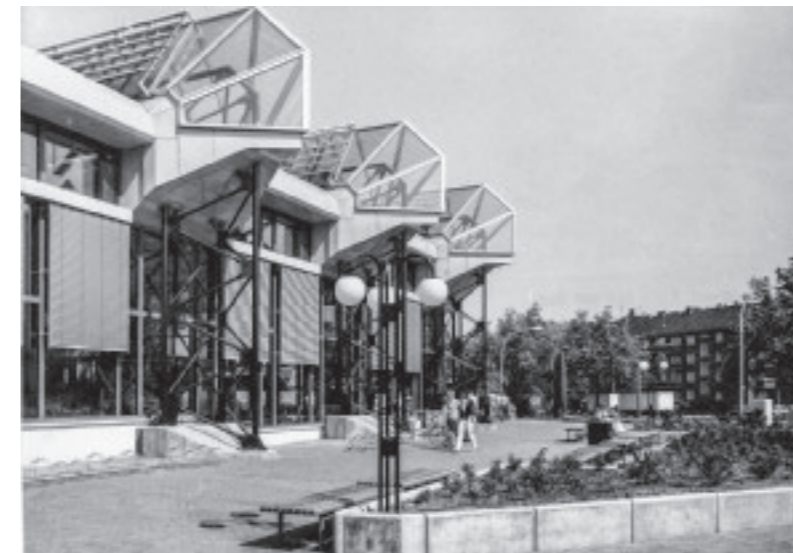
Markantes Erscheinungsmerkmal: die prominente Straßenfassade mit den verglasten Binderköpfen. Dem begeisterten Berliner Publikum ermöglichte die durchlässige gläserne Fassade Einblicke in die Badelandschaft. Unten: Aus der Vogelperspektive allein lässt sich die durchdachte Kleinteiligkeit des monumentalen Baus kaum erschließen, inszeniert jedoch das großzügige Raumangebot mit städtebaulich ausdrucksstarker Geste. Fotos: IRS(Erkner), Wiss. Samml., Bildarchiv (Bln.-Friedrichshain, D1_1_3_5001, D1_1_3_5_002, D1_1_3_5_003), Gerd Danigel (linke Seite, großes Bild)
