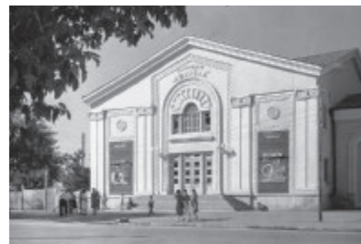
Stuckstadt: Zwei-Saal-Kino „Ashgabat“ am Stalin-Prospekt, 1950. 2008 wurde es abgerissen. Quelle: Archiv Ruslan Muradow
