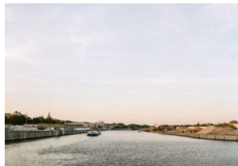
Links der Bau von Tetra Architecten, dahinter der Park de Laeken. Foto: Severin Malaud
