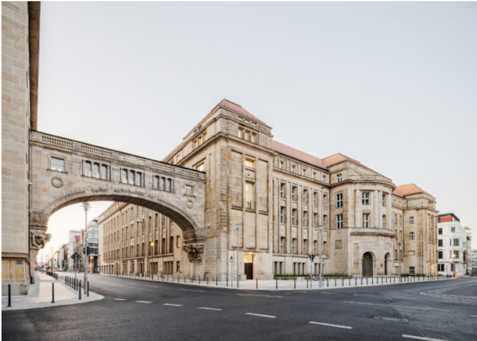
Haus 2 des Ministerienkomplexes bietet im Trakt an der Mauerstraße ein Konferenzzentrum, das auch von anderen Ministerien genutzt werden kann.
