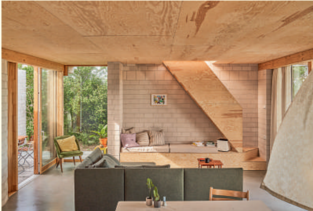
Der robuste Fußboden aus geschliffenem Estrich ergänzt den Betonstein. Fenster, Decke und Einbauten sind aus Holz.
