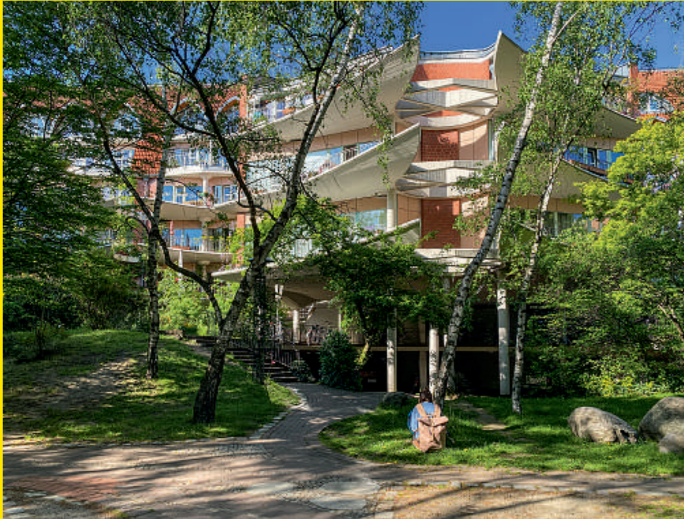
Wohnhäuser am Fraenkelufer in Berlin-Kreuzberg (1980–84), hier die Bebauung entlang der Brandwand im Innenhof. Foto: Benedikt Hotze; Grundriss 1.–3. OG: Inken Baller und Hinrich Baller
