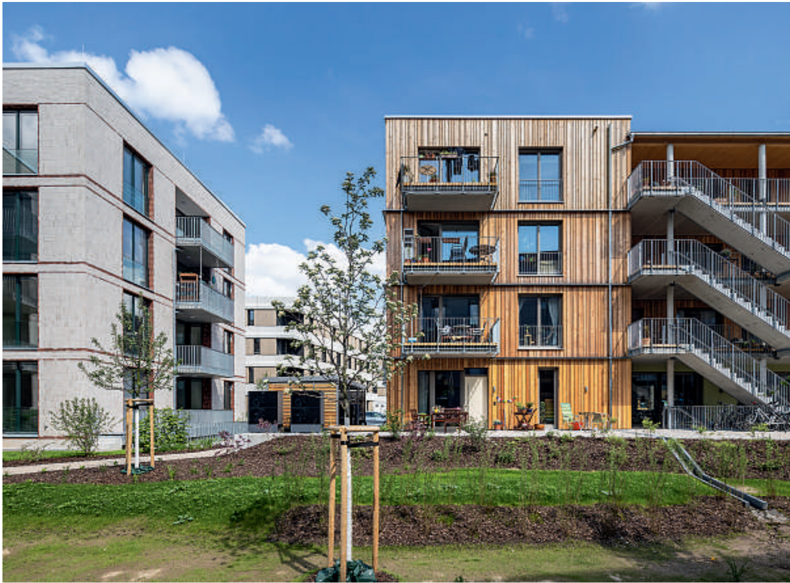
Das Holzgebäude wurde von der Genossenschaft Oikos gebaut und von der PLANWIRKSTATT Karin und Ralf Vogel Architekten entworfen. Es beinhaltet 21 Wohnungen, einen Gemeinschaftsraum und Gemeinschaftsflächen.
