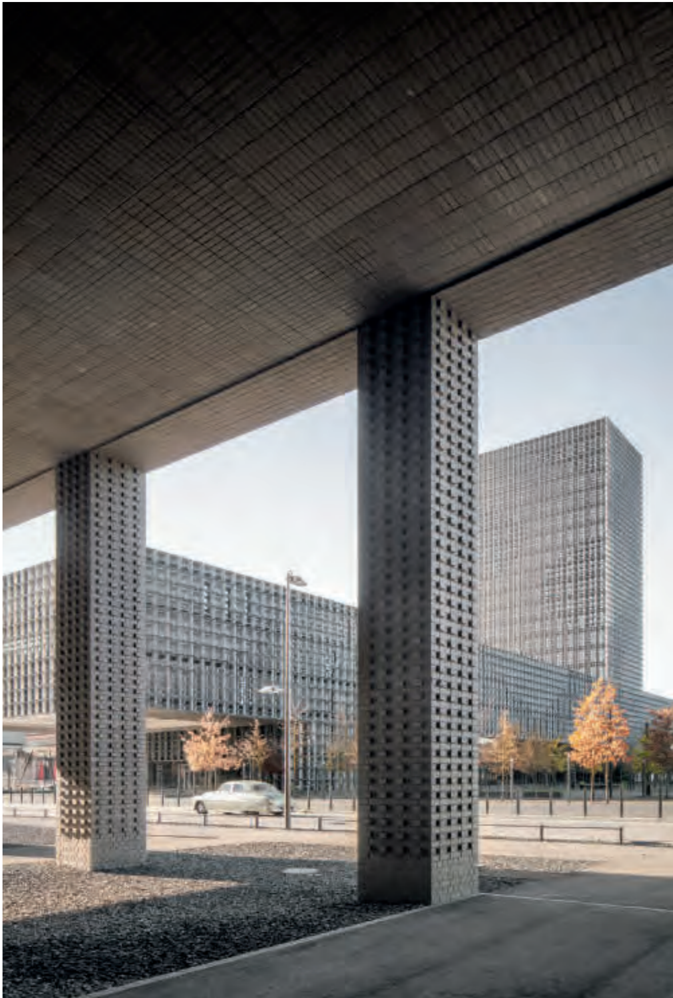
Die kleinteilige Klinkerhaut der „Maison des Matériaux I“ wirkt wie eine Übersetzung des abstrakten Quadratrasters des Hauptgebäudes schräg gegenüber ins Handwerkliche. Lageplan im Maßstab 1:5000
