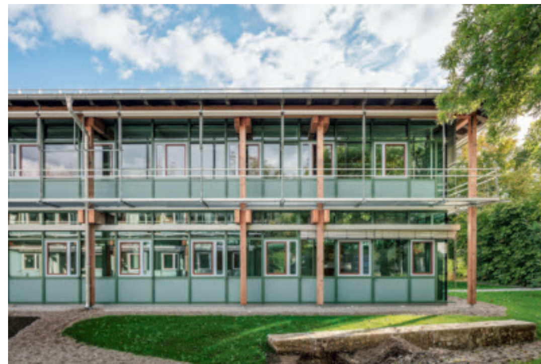
Die modulare Tragkonstruktion ermöglicht eine individuelle Einteilung der Büroräume nach Bedarf.
