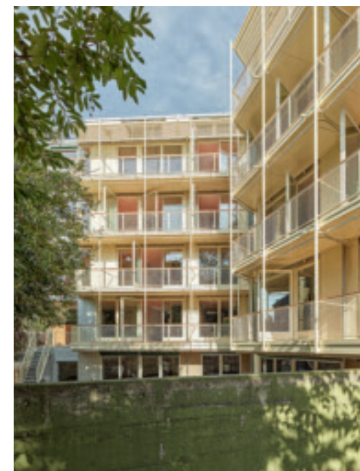
Der vorfabrizierte Holztafelbau mit Wänden und Decken aus Massivholzplatten (CLT) baut auf dem bestehenden Untergeschoss auf. Foto unten links: ©moyreal immobilien ag/Roland Bernath, Grundrisse Untergeschoss, Erd-, Regel- und Dachgeschoss im Maßstab 1:333
