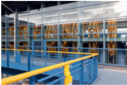
Aufgereichte, motorenbetrie- bene Seilscheiben heben und senken den Trog und die Betongewichte. Unten: Blick in die imposante, an ein Kirchenschiff erinnern- de Tiefe des 55 Meter hohen Gebäudes. Fotos: oben links: Florian Thein; WNA
