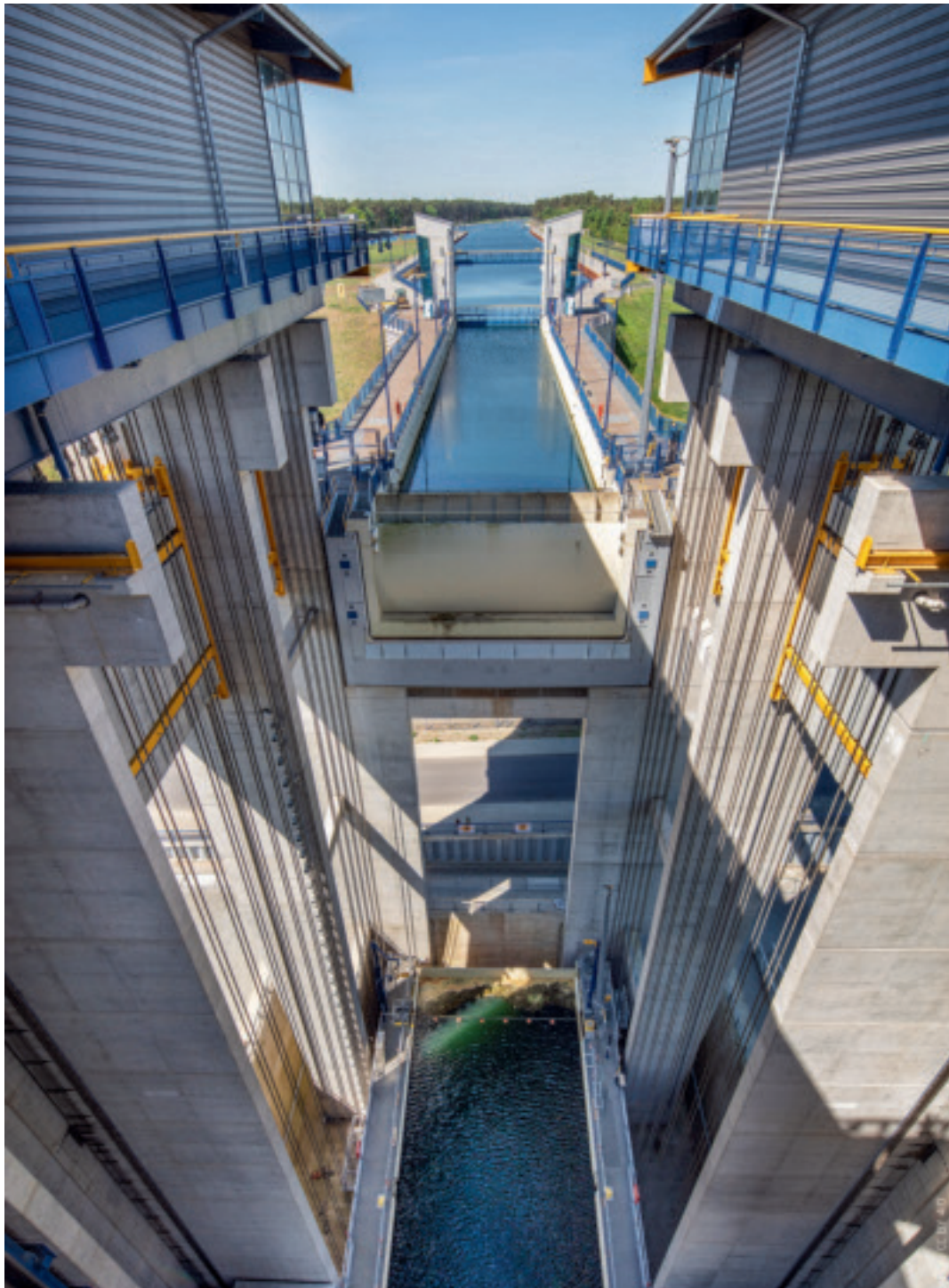
Aufgereichte, motorenbetrie- bene Seilscheiben heben und senken den Trog und die Betongewichte. Unten: Blick in die imposante, an ein Kirchenschiff erinnern- de Tiefe des 55 Meter hohen Gebäudes. Fotos: oben links: Florian Thein; WNA
