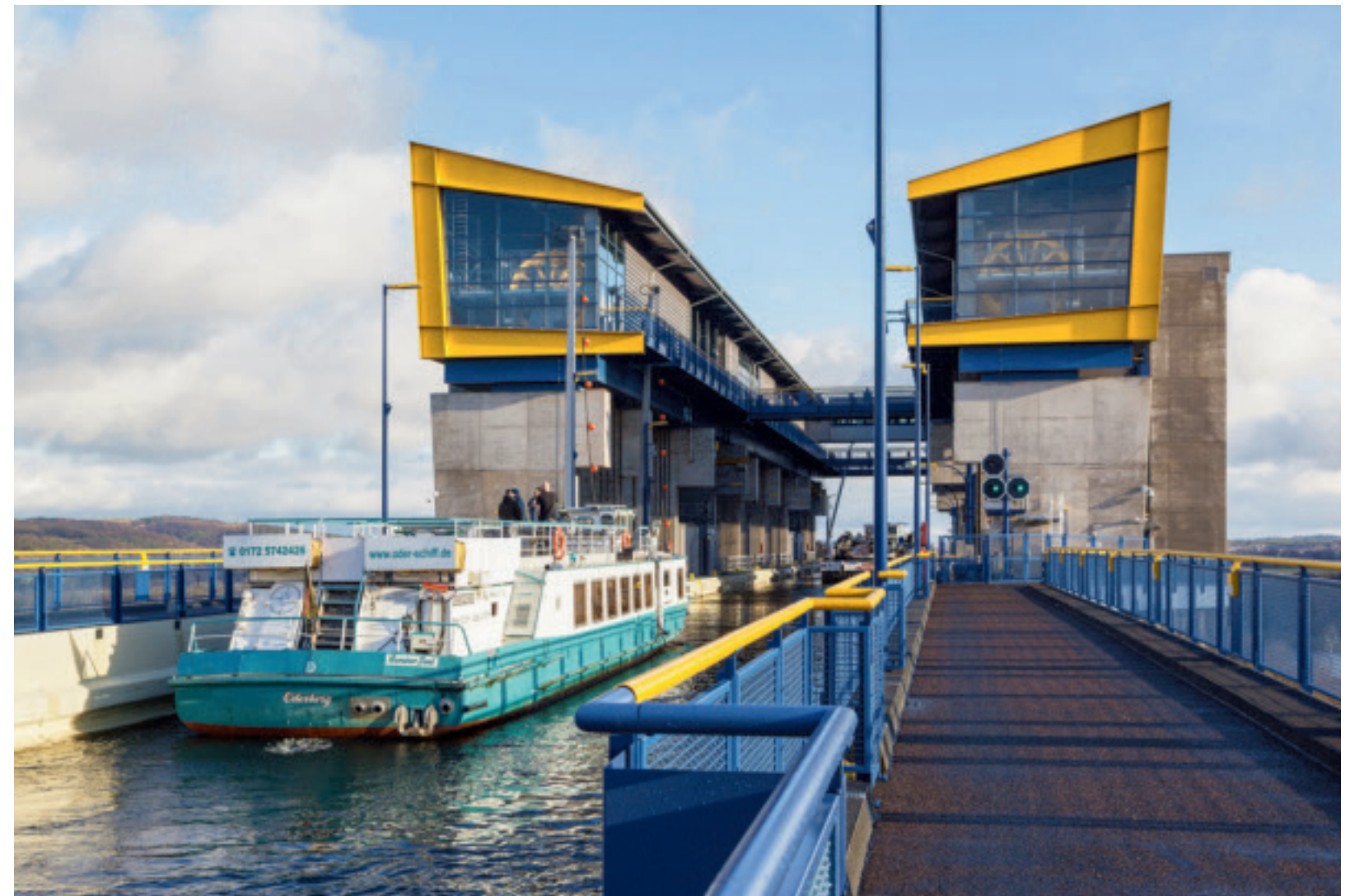
Der neue Trog hebt zwei- lagige Container- und Groß- motorenschiffe mit bis zu 110 Meter Länge. Noch liegen die Fahrzeugzahlen aber hinter der Prognose zurück. Links: Gegengewichte und Trog in Wechselbewegung. Fotos: Florian Thein; Längsschnitt: WNA. Maß- stab: 1:1500
