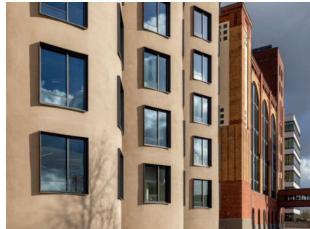
Zwei Fenster je Röhre und Geschoss waren erlaubt; Blick entlang des Betonsilos und des dahinterliegenden, auf einer Holzkonstruktion basierenden Silos mit Mauerwerk. Unten: Das Betonsilo und seine Erweiterung von 1934. Foto unten: Stadtarchiv Düsseldorf
