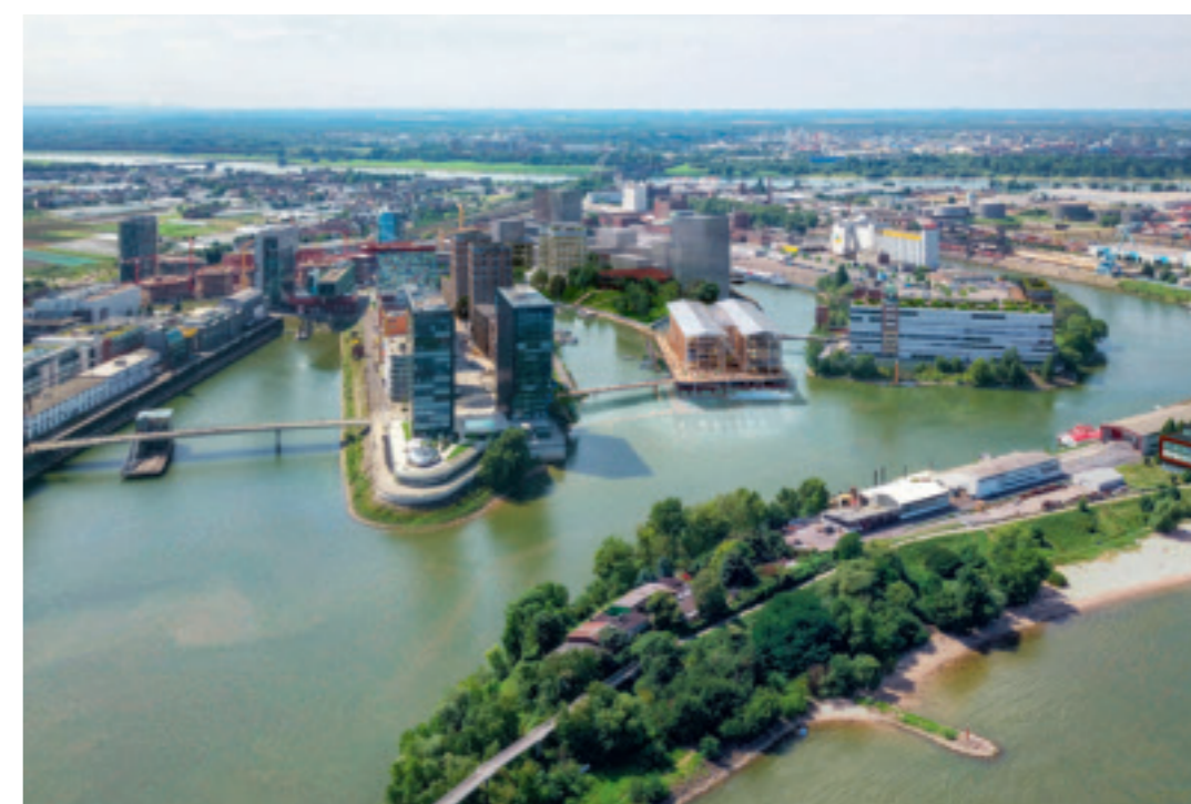
Zukunftsvision: Bis 2026 wollen ingenhoven associates den Neubau „Pier One“ errichten, der über dem Wasser auf Pfählen ruhen soll (rechts der Bildmitte).
