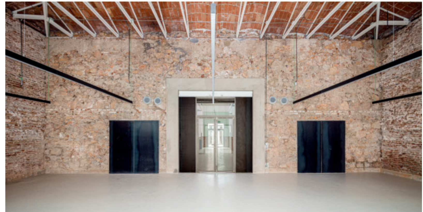
Eingriffe wie etwa neue Deckenbinder bleiben filigran und heben sich deutlich vom Bestand ab. Immer wieder ergeben sich Blickbeziehungen zwischen den Teilbereichen.
