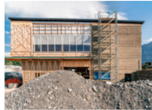
In der 67 auf 24 Meter großen Erden Werkhalle in Schlins werden Stampflehm-elemente fabriziert. Der Kopfbau für die Verwaltung ist derzeit im Bau.
