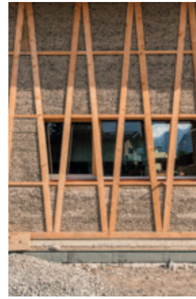
Die Halle besteht aus einer durchgehenden Stampflehmwand im Süden; im Norden entschied man sich für eine Holzkonstruktion mit V-Stützen zur Queraussteifung in Anlehnung an den traditionellen Fachwerksbau. Das Gefach ist mit einem stabilen Gemenge aus Hackschnitzel und Lehm gefüllt.
