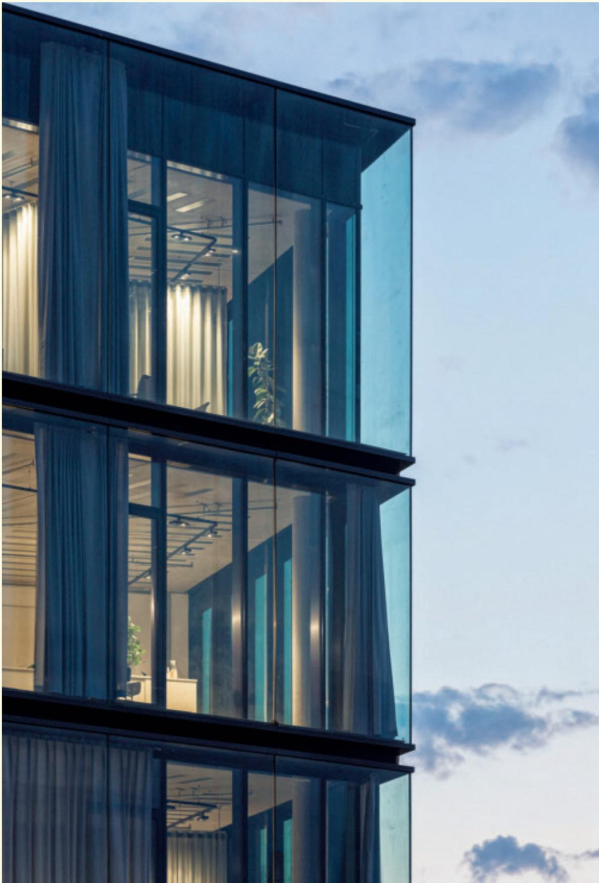
In die Doppelfassade wurde ein vollautomatisches Vorhangsystem integriert. Die Vorhänge folgen dem Lauf der Sonne und verändern so das Erscheinungsbild des Bürohauses.
