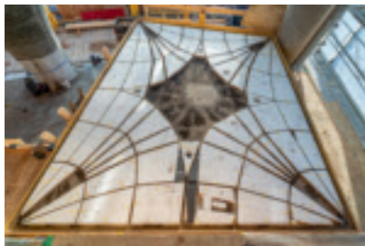
Oben: Schalung für die Leichtbau-Gewölbedecken mit Aussteifungsrippen auf der Westseite. Unten: Ansicht nach dem Betonieren. Foto: ETH Zürich, Block Research Group/Juney Lee
