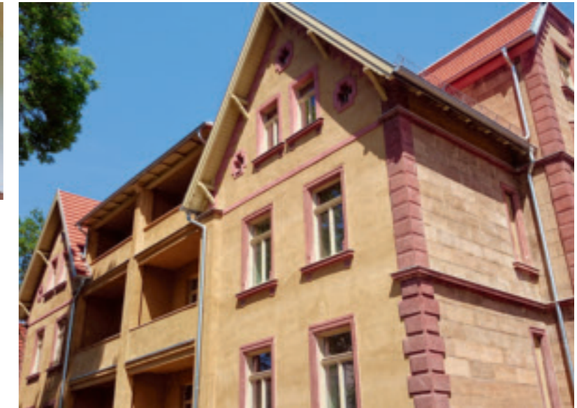
Das Mietshaus in der Jenaer Straße wurde denkmalgerecht saniert. Im verwilderten Garten entstand eine Fläche für die Mietergemeinschaft. Fotos: Anselm Graubner
