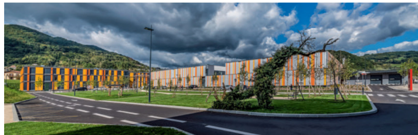
Pflege und Behandlung wurden vor der Kulisse der Voralpen nebeneinander angeordnet. Die Dachflächen sind begrünt. OP-Saal im „Plateau Technique“ mit Fenster und den farbigen Lamellen Fotos: Denis Morel
