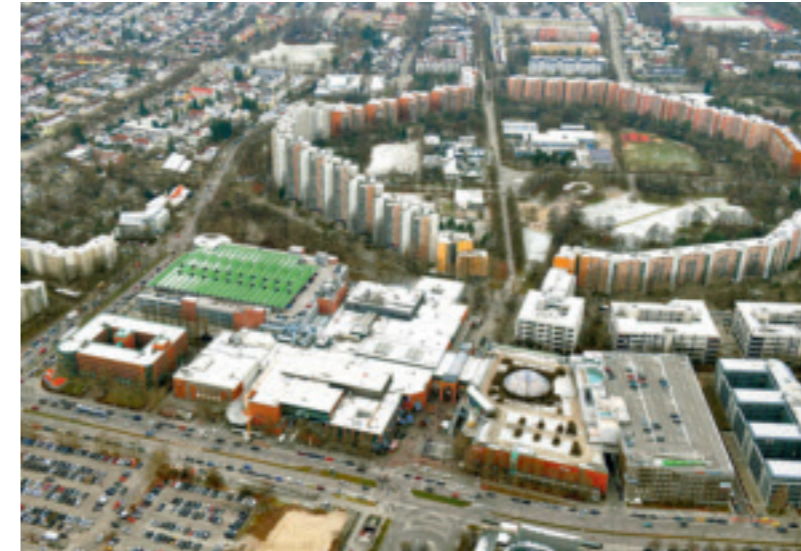
München Neuperlach: Die geballten Baukörper des Einkaufszentrums PEP auf der Ostseite des „Wohnrings“ mit einem Durchmesser von 450 Metern Foto: Euroluftbild/Robert Grahn
