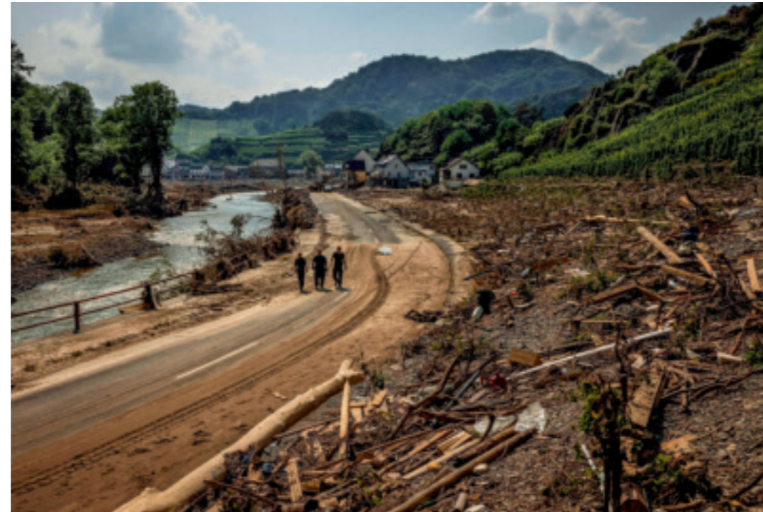
Das gesamte Ahrtal in Rheinland-Pfalz wurde stark beschädigt.
