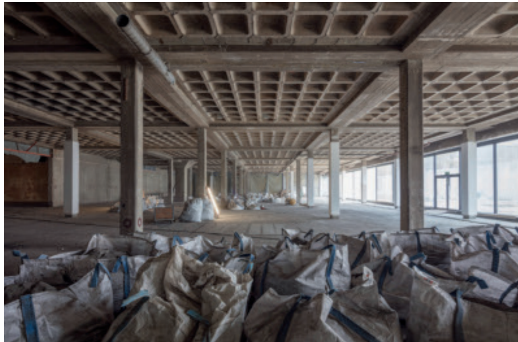
Die Rückführung der Ausstellungsräume im Sockelgeschoss bis zum Rohbau. Wände, Unterdecke und Teppichboden wurden neu wieder eingefügt. Rechts der Tiefgarten. Foto: Thomas Bruns
