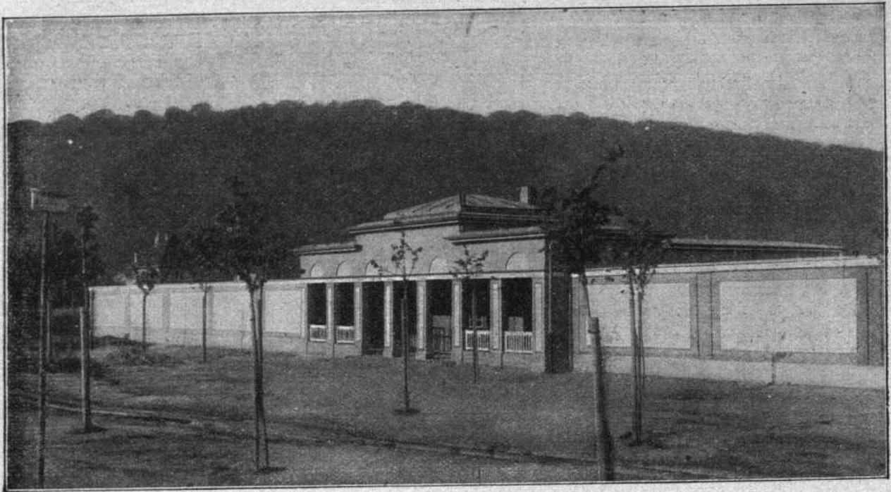
Abb. 1. Blick von der Heinrichsbrücke mit Ansicht der Eingangshalle des Sommerbades
