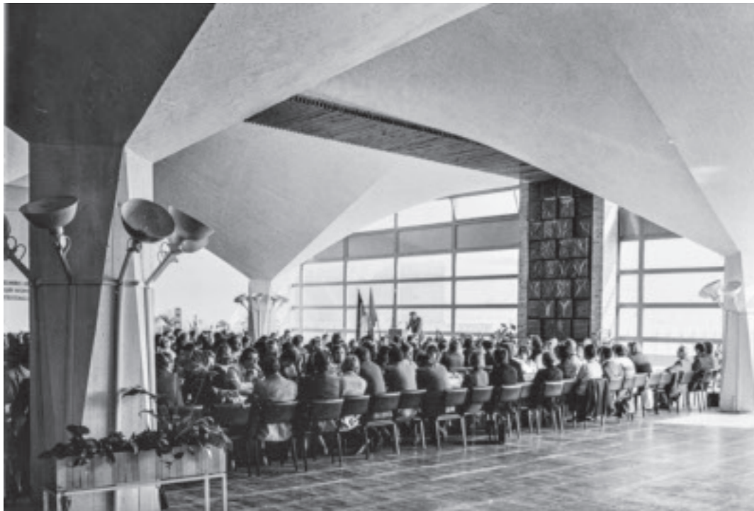
Die Alte Mensa in Wismar soll demnächst für eine Büronutzung umgebaut werden. Sie hat drei Speisesäle mit Schirmschalen. Oben: Großer Speisesaal, 1975. Rechts: Modell des Gebäudes. Fotos: Mütter-Archiv Wismar; Archiv der Hochschule Wismar
