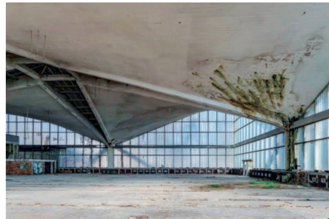
Die Hyparschale in Magdeburg war stark korrodiert, sie wird aktuell mit Carbonbeton saniert. Foto: Martin Maleschka
