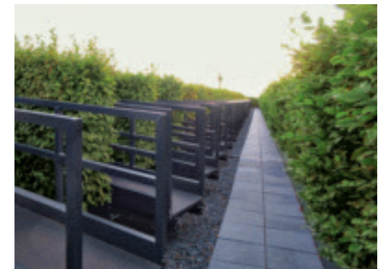
Auch auf dem leicht geneigten Dach wechseln sich Hecken und die Stege für die Gärtner ab. Das Dach ist nicht öffentlich zugänglich. Bild linke Seite: Notausgang auf der Nordseite zum Gustaf-Gründgens-Platz. Fotos: Sebastian Redecke
