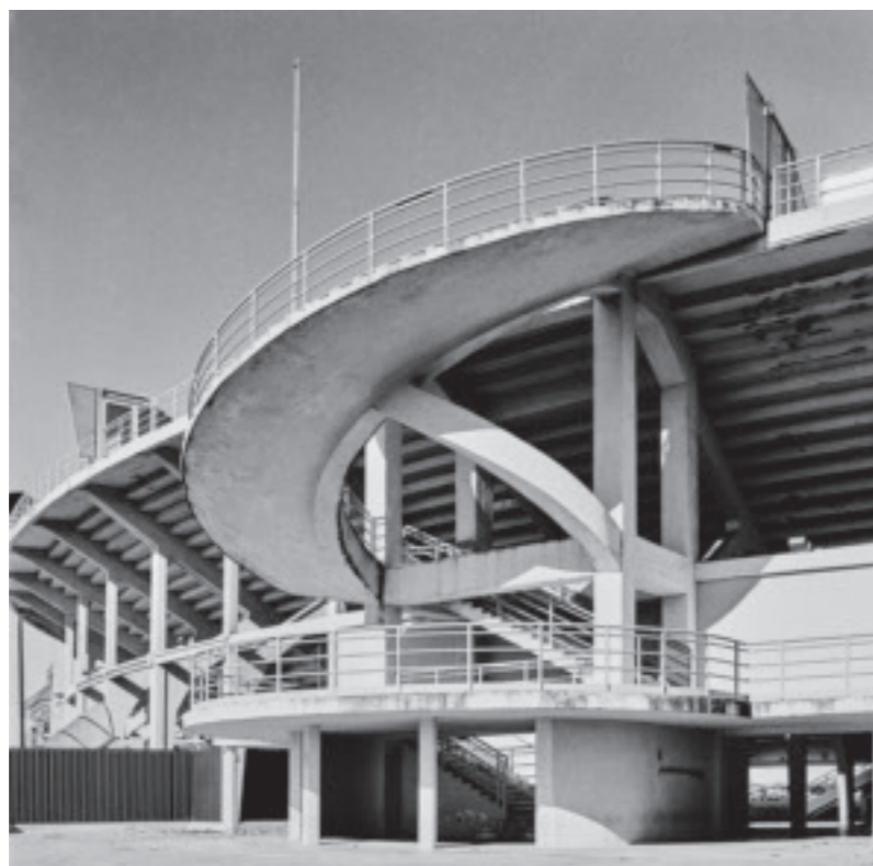
Die außen anliegenden Aufgänge der offenen, leicht wirkenden Tribünenkonstruktion fallen besonders ins Auge. Von Nervi stammt auch das 23 Meter auskragende Dach der Haupttribüne. Das Stadion verfügt über 43.000 Sitzplätze. Fotos: Marco Menghi (links); Matteo Cirenei (rechts); Nervi Project Association (Modell)
