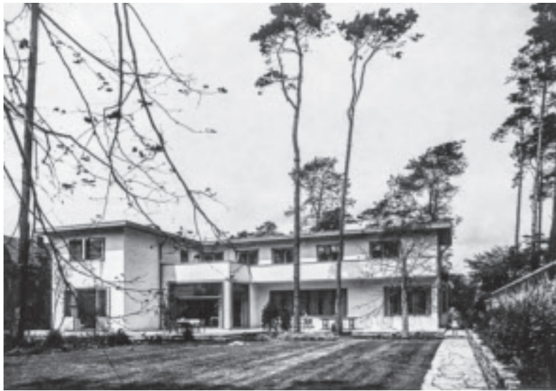
Die Gartenseite der Villa kurz nach ihrer Fertigstellung. Die kleine Terasse im ersten Obergeschoss diente zum Sonnenbaden. Fotos: Wasmuths Monatsheft 14, 1930
