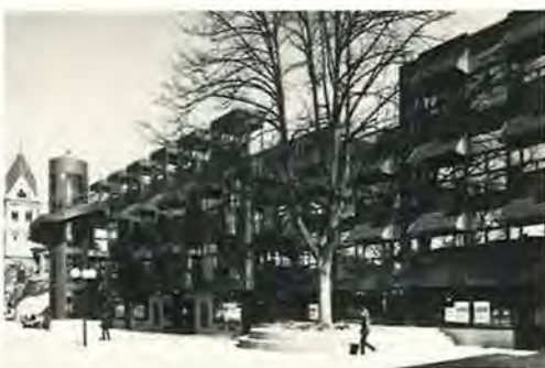
Der sorgfältige wiederhergestellte Altbau mit Gaststätte ist ohne Anpassungskompromisse in die Gesamterscheinung einbezogen. Ein hochliegender Hof mit Läden und Dienstleistungseinrichtungen zwischen Altbau- und Neubauteil liegt am (noch geplanten) Weg vom Marienplatz über die Dachterrasse und einen Fußgängersteg zur künftigen Bebauung südlich der Entlastungsstraße. Siehe dazu auch Lageplan auf Seite 1225.
