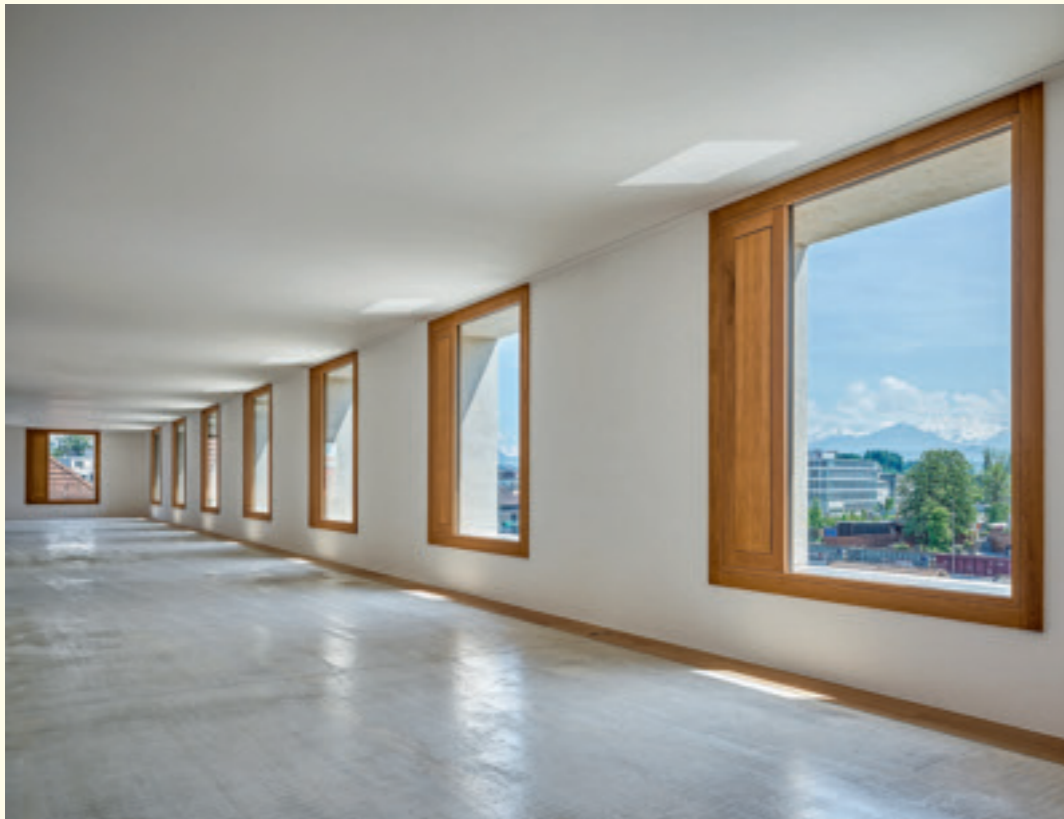
Für Temperaturstabilität sorgt ein knapp 80 cm dickes, zweischichtiges Mauerwerk. Schnitt und Grundriss Erdgeschoss im Maßstab 1:500
