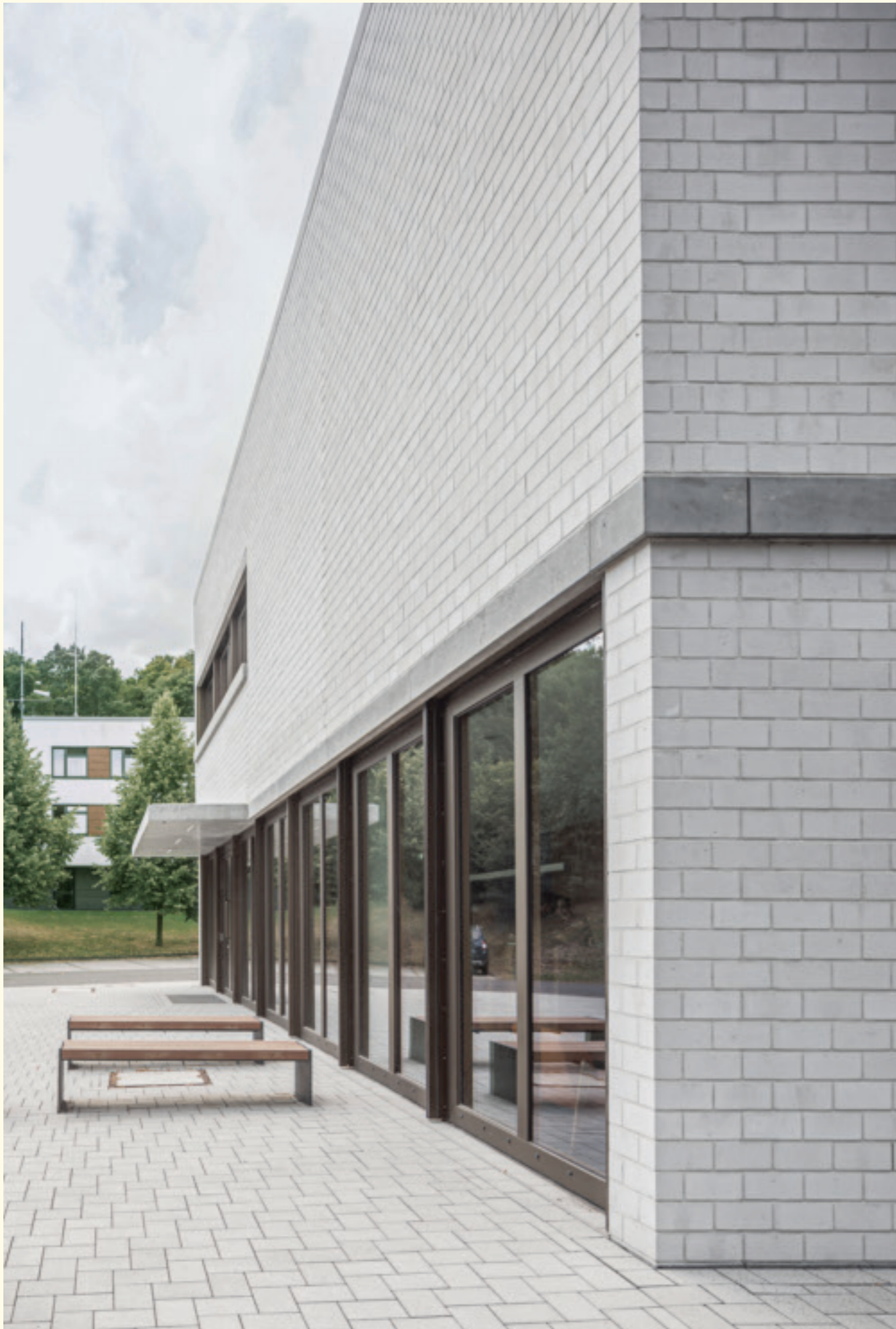
An Feinheiten wie dem leicht unter dem Betongesims nach innen zurücktretenden Erdgeschoss wird deutlich, wie sorgfältig die Architekten den Bau auch im Detail entworfen haben
