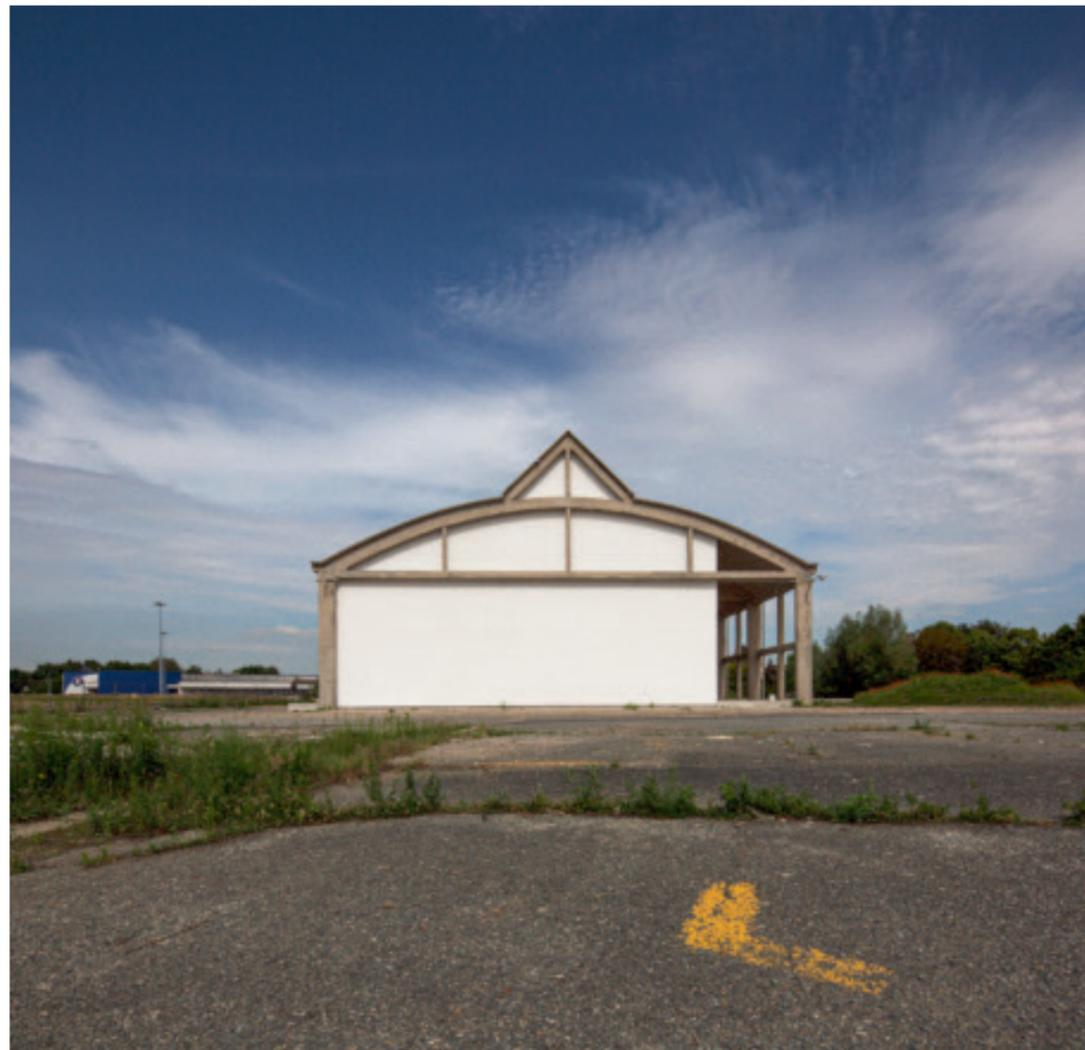
Die Halle von 1919 (rechts) ist dreischiffig aufgebaut, die Stahlbetonteile sind filigraner ausgeführt als die des Abschnitts von 1949 (links).
