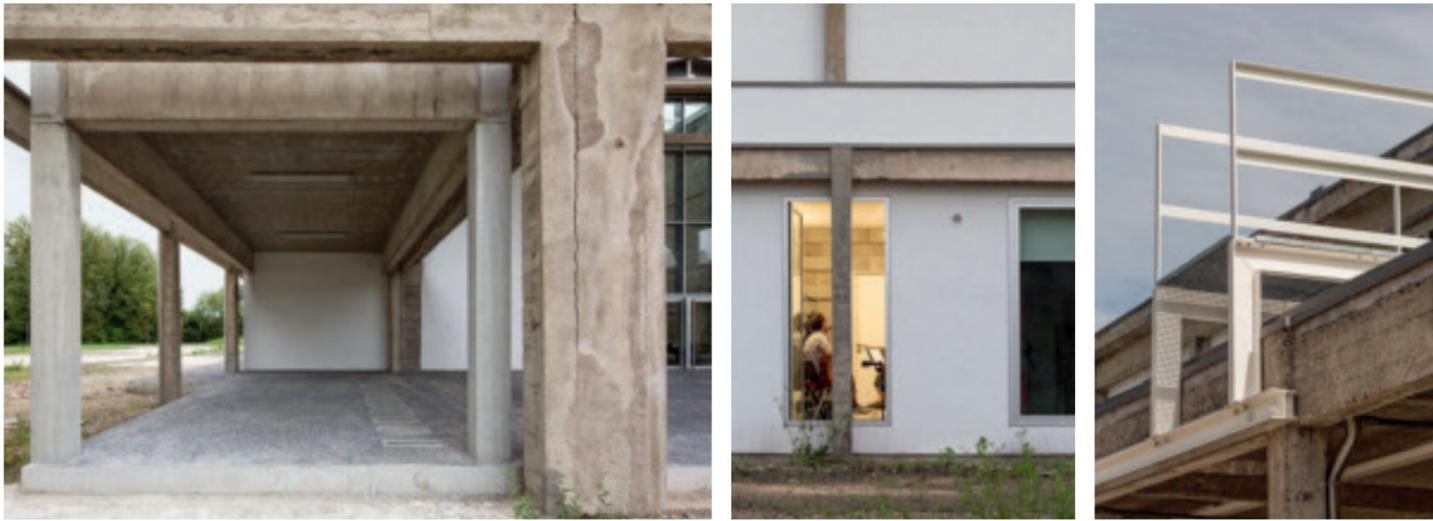
Die Altbausubstanz ist Schild, nicht Träger der Musikräume im Seitenschiff (links). Das verdeutlichen die Architekten durch die Loslösung der neuen von der alten Fassadengliederung (Mitte). Wo sie dennoch auf das Vorgefundene bauen mussten, benötigte die Struktur bisweilen Unterstützung. Ästhetisch wie substanzuell unterstreicht die Wahl offener Stahlprofile die Unterschiedlichkeit des Eingriffs (rechts).
