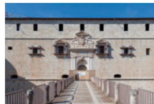
Die vom Erdbeben beschädigte Eingangsseite des Castello ist inzwischen restauriert, doch bis zur Wiedereröffnung werden noch Jahre vergehen. Rechts das Auditorium von Renzo Piano
