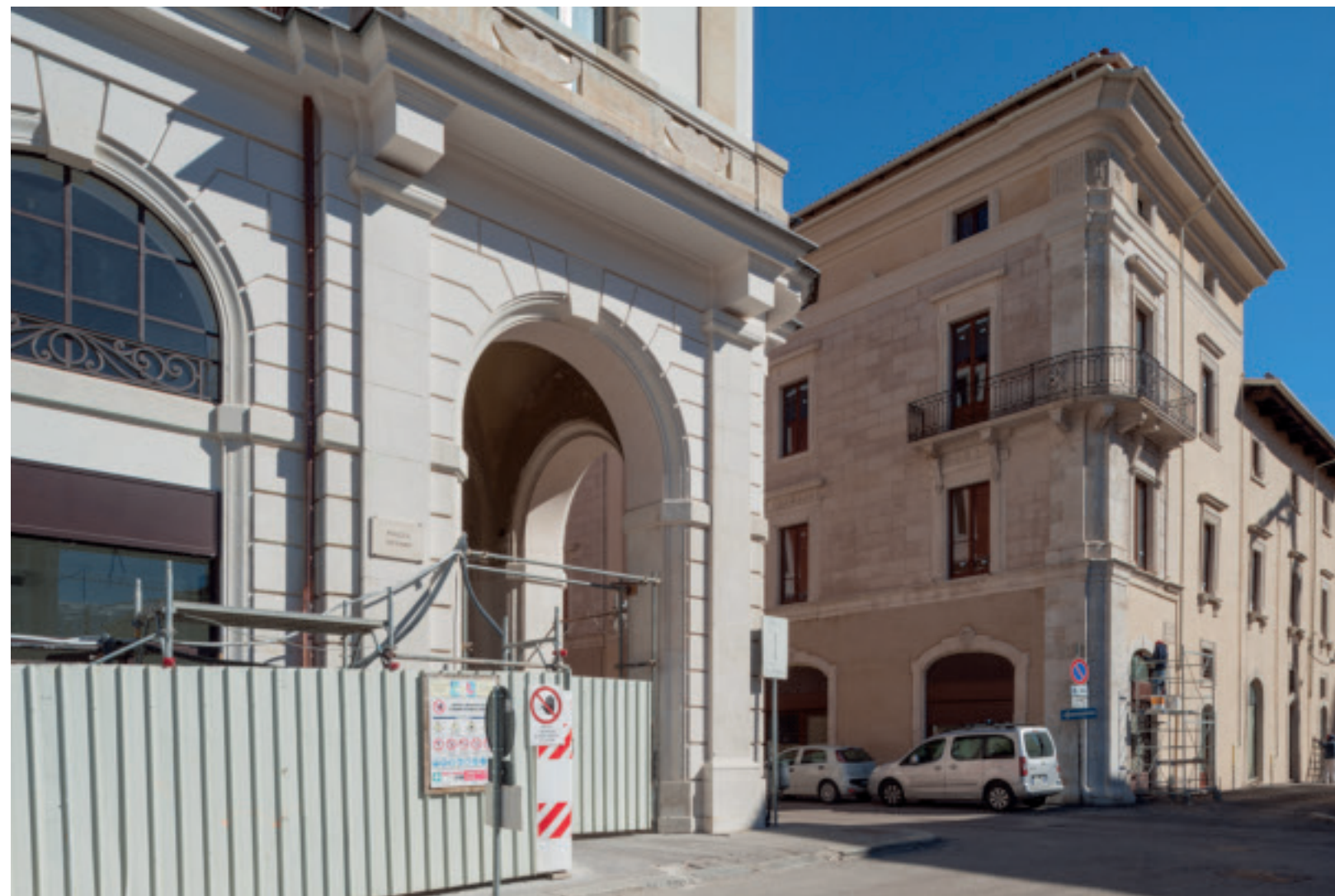
Domplatz, Ecke Corso Vittorio Emanuele: Die Restaurierung an den zentralen Räumen der Stadt ist inzwischen weit fortgeschritten, die Zona rossa aufgehoben.
