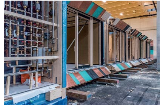
Montage der Module in der Werkshalle und deren Einbau in das zweite Geschoss des Experimentalbaus in Dübendorf; links im Bild zu sehen sind die Montage-schienen, auf die die Module mit Hilfe des Krans aufgesetzt werden.
