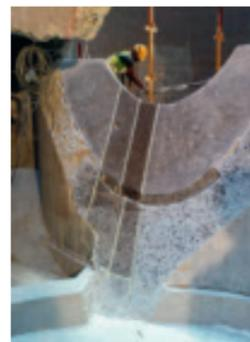
Da die 42 Betonzylinder ein geschlossenes statisches System bildeten, musste vor dem Aufsägen eine zweite Betonschicht in die Zylinder eingebracht werden.
