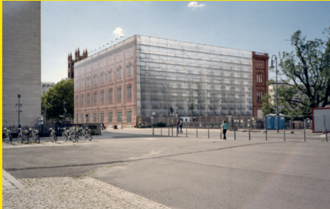
Der Ist-Zustand am Ort der geplanten Wiedererrichtung von Schinkels Bauakademie. Wie lange das Mockup aus Plastikplane (hier teilweise zurückgebaut) noch erhalten bleibt, ist ungewiss.
