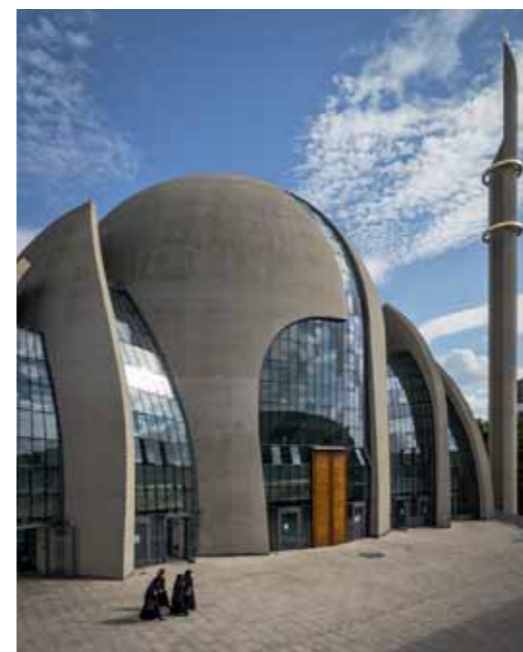
Der Eingang zum Gebetsraum führt über den höher gelegenen, städtischen Platz. Grundrisse und Schnitt im Maßstab 1:750
