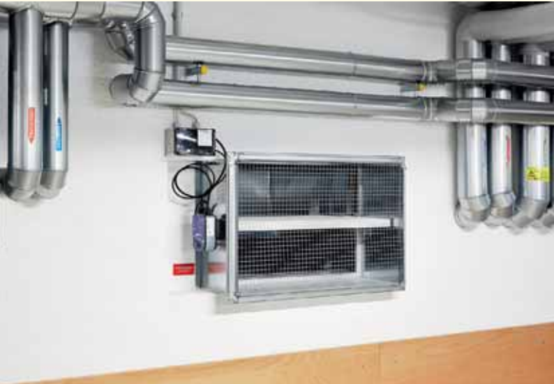
Brandschutzklappen TROX-FK-EU in quadratischer oder rechteckiger Bauform zum Absperren von Luftleitungen zwischen zwei Brandabschnitten. Die funktionsfertige Einheit enthält ein feuerbeständiges Klappenblatt und eine Auslöseeinrichtung. Fotos: Trox
