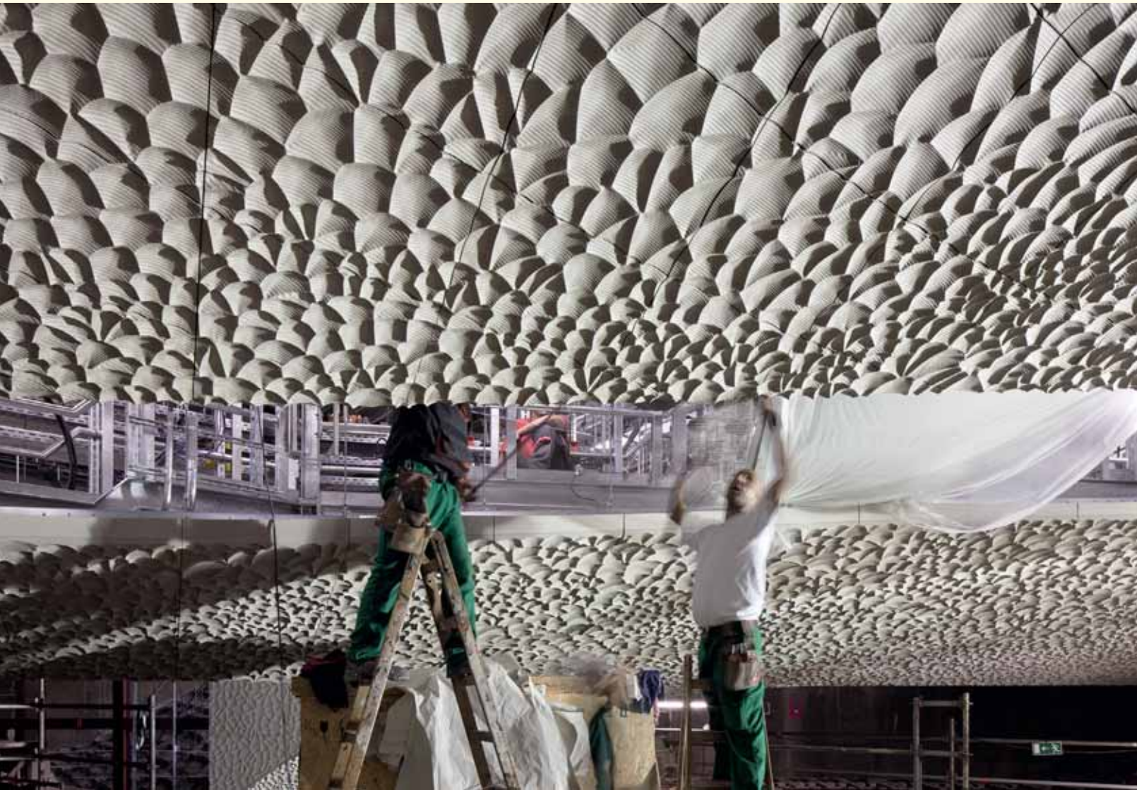
Montage der „Weißen Haut“ im Großen Saal. Die 10.000 3-D-gefrästen Akustik-Gipsfaserplatten sind alle unterschiedlich gestaltet. Foto: Oliver Heissner
