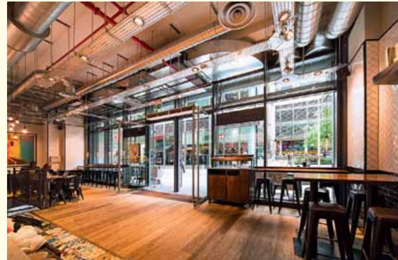
Klimasystem ohne Außengerät. Ein Verdichtermodule (im Londoner Restaurant Leon fand es in einem Schrank unter der Treppe Platz) und eine Wärmetauscheinheit (in die Decke integriert) ersetzen das vormalige Außengerät. Fotos: Daikin
